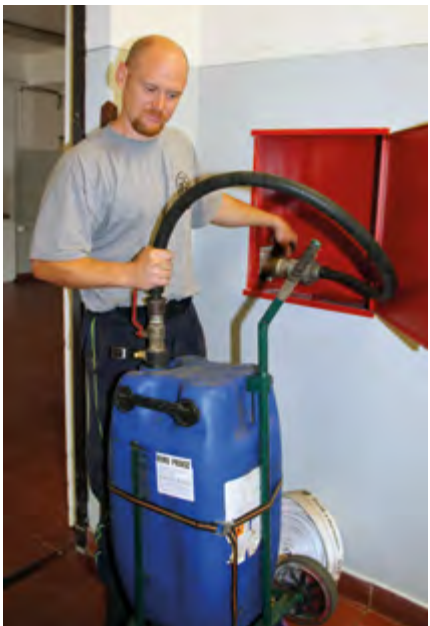
Jaroslav Kois při tlakové zkoušce během revize hydrantu požární vody.
